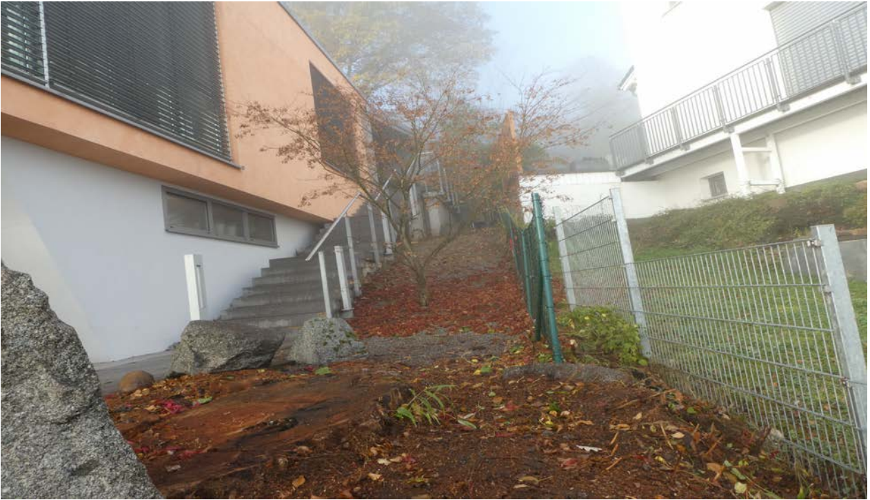
Bild 8: Gleiche Blickrichtung, einige Meter weiter oben: Der grüne private Zaun, der von dem Anlieger links errichtet wurde, steht auf dem öffentlichen Wegegrundstück und muss wohl entfernt werden.
