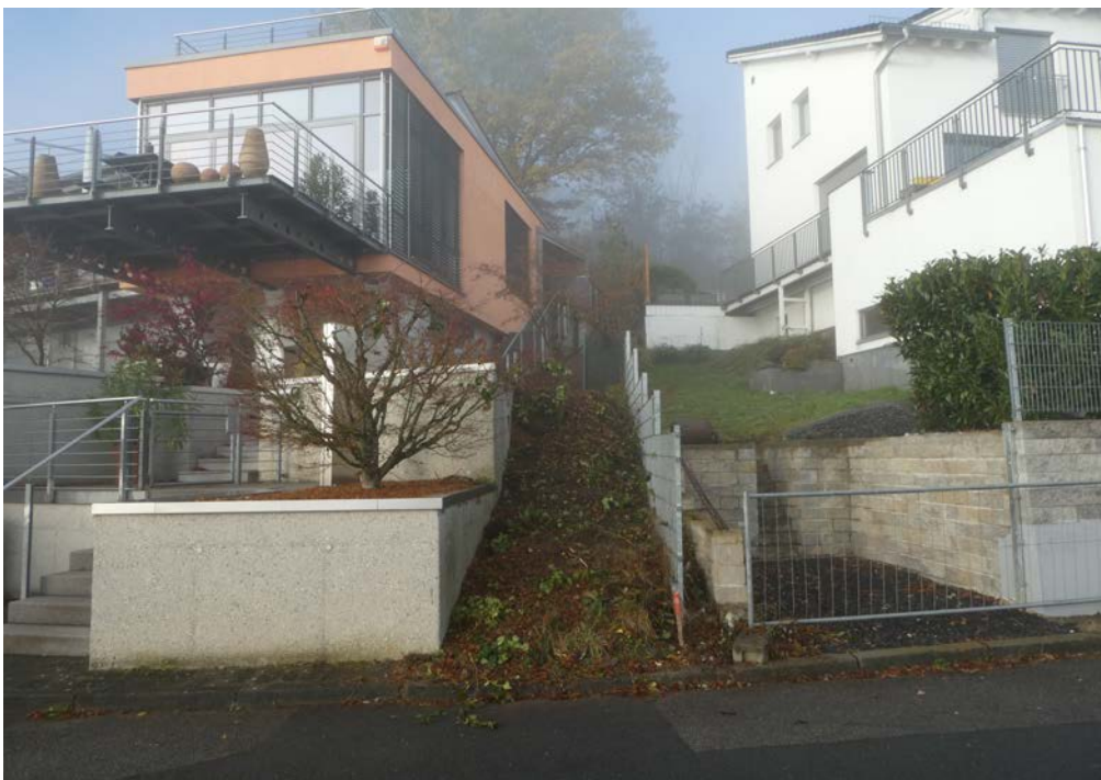
Bild 7: Zustand im Nov. 2020: Der Eigner des Hauses links hat mit Rodungsarbeiten begonnen, um den öffentlichen Weg wieder begehbar zu machen. Blick hangaufwärts von der Straße "Am Büchsenackerhang".
