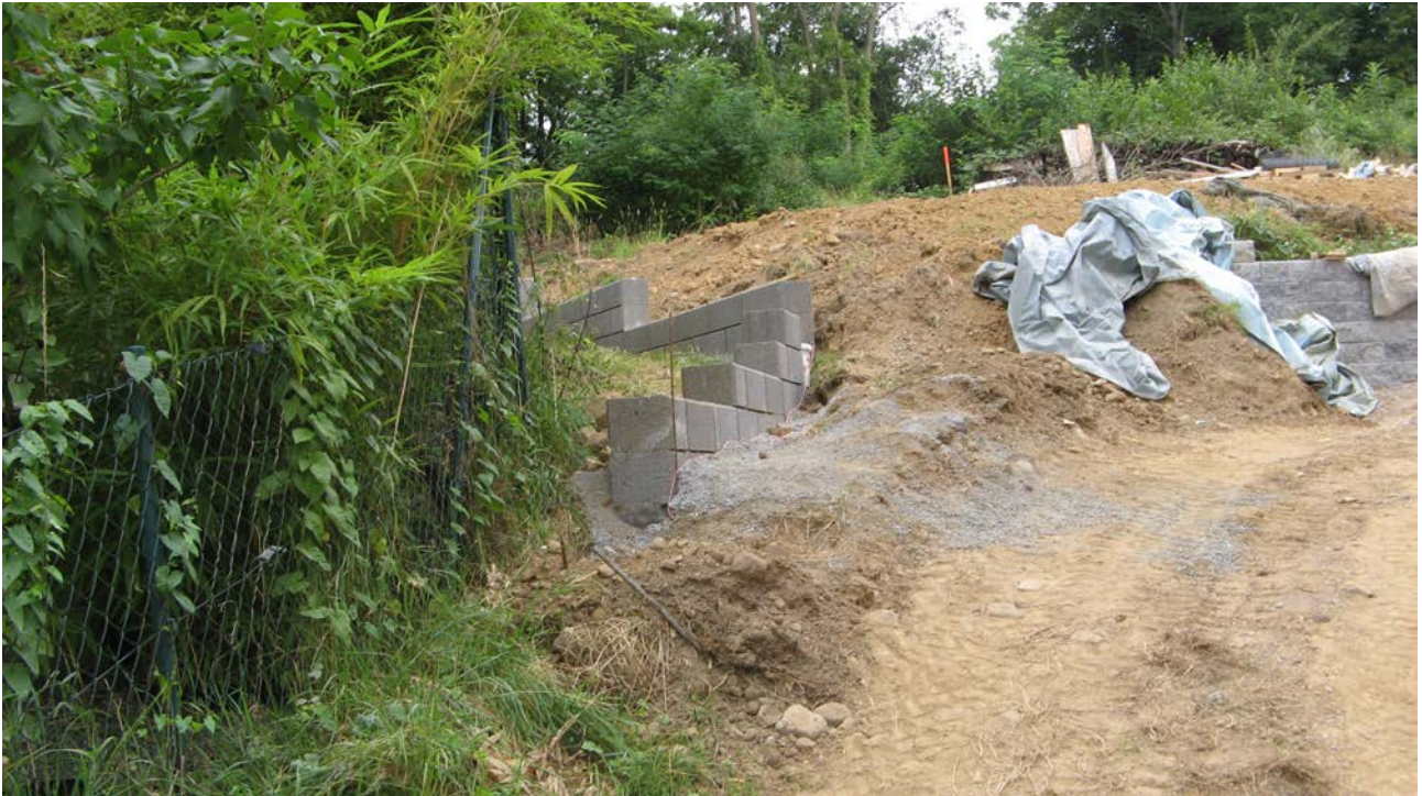
Bild 2: Einige Wochen später: Der Eigner auf der rechten Seite grenzt sein Grundstück durch eine Sockelmauer ein, die später den Zaun tragen soll. Damit entfällt für die Fußgänger die Möglichkeit, den versperrten Teil der Rosensteige auf seinem privatem Grund zu umgehen.
