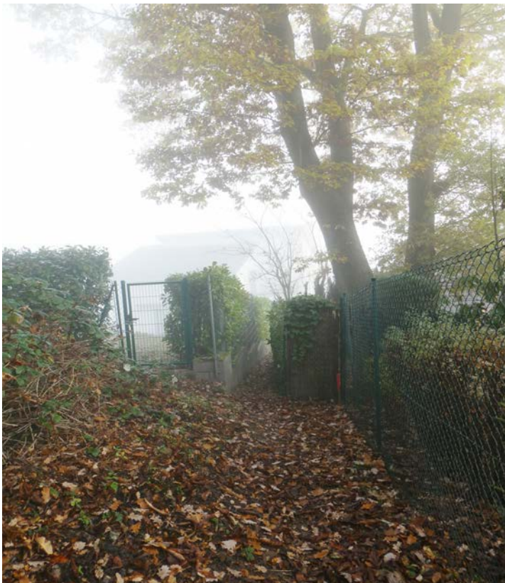
Bild 5: Einige Meter weiter oben wurde der private Zaun bis auf die Mitte des Weges verschoben. Der öffentliche Grund reicht von dem Vermessungspflock (rechts am Baumstamm, rot) bis zu der Mauer mit Zaun links.
