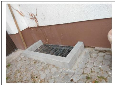
Geförderte Maßnahme im Rahmen des Förderprogramms Starkregen und Hochwasserschutz der Stadt Heidelberg: Die Aufkantung eines Lichtschachtes.
